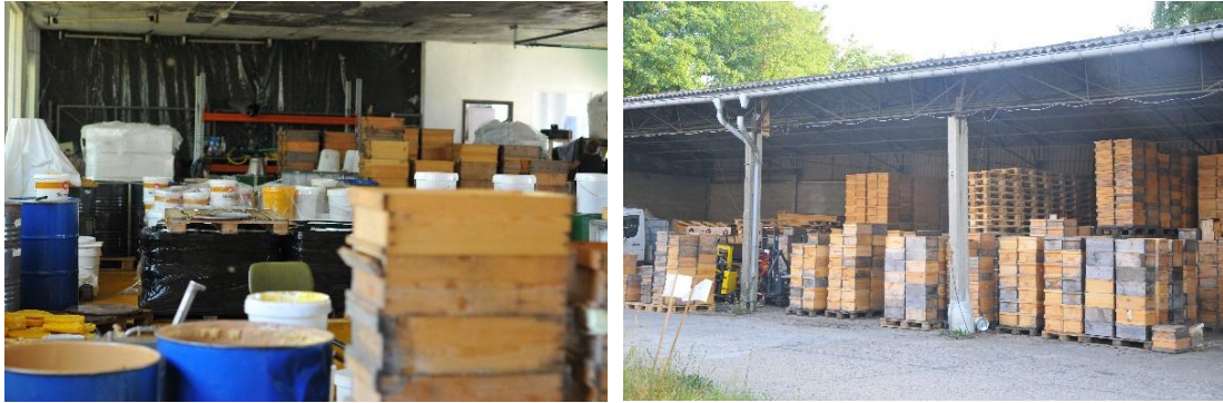
Le bâtiment de production et l'entrepôt.
